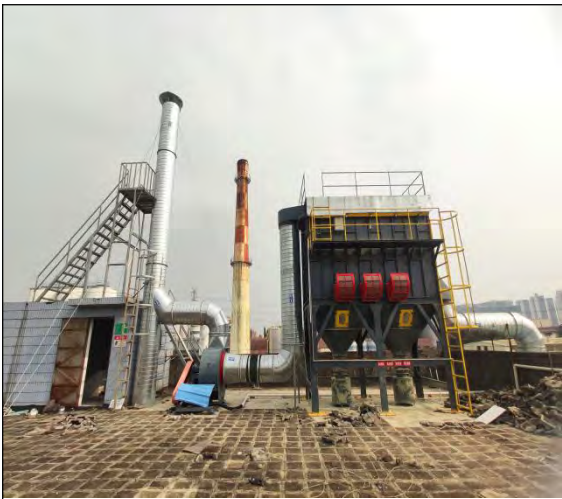
废气采样口（旋风除尘+布袋除尘）
